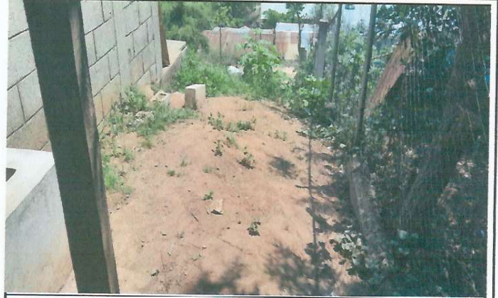
mejoramiento y ampliación de baños.
