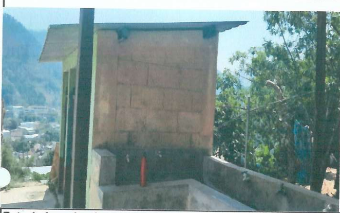
Foto 1: Area donde se encuentran los baños y lavamanos
